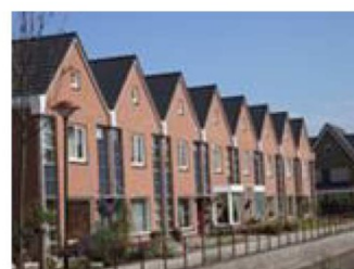
Aanpassingen aan een rijtjeswoning dienen in relatie te staan tot het gehele woningblok
